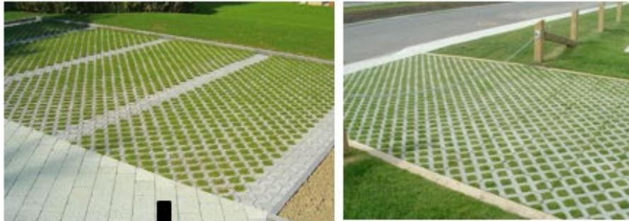
Structure béton alvéolé engazonnée
