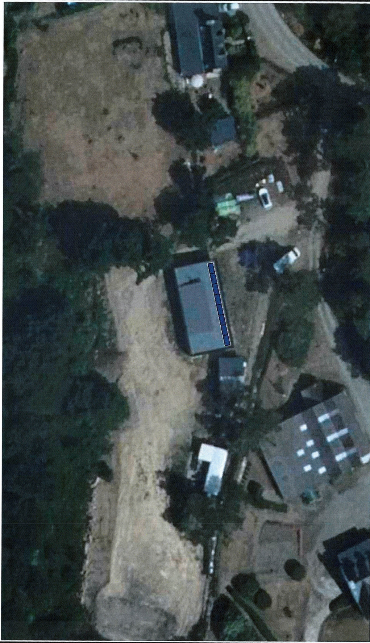
DP5 / DP6 (TOITURE)
