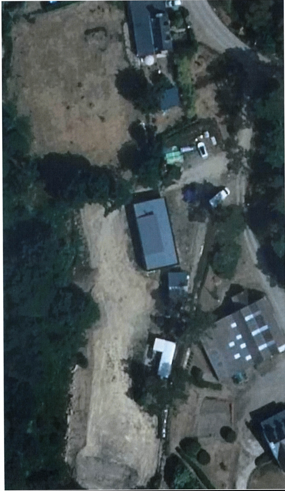
DP5 / DP6 (TOITURE)
